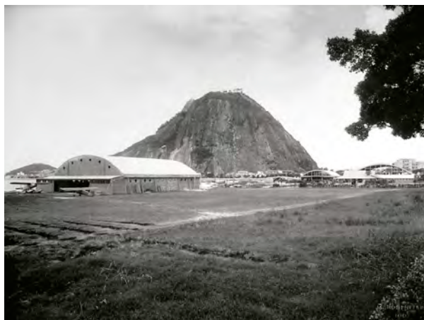
A pista da aviação, quando já concluídos os hangares 1, 2 e 3.
